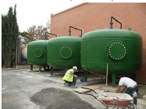
Foto 156: Pavimentació de vorera a la zona dels filtres.
