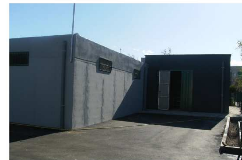
Foto 161: Façana de la sala de bombes .27.10.08
