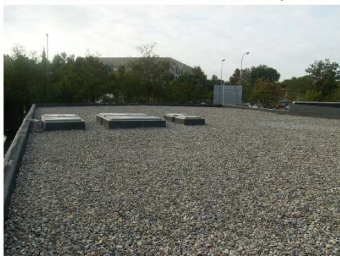
Foto 157: Vista general del forjat finalitzat.
