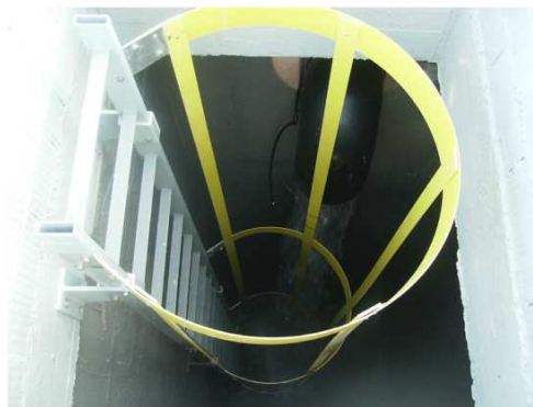
Foto 158: Detall del interior de l'accés al dipòsit
